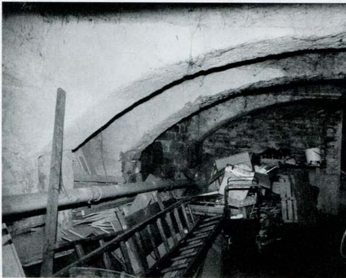
Heute noch erhaltener Schürraum mit Gewölbedecke aus Ziegelstein der ehemaligen Ziegelei Christian Seewald, Merchweiler.
