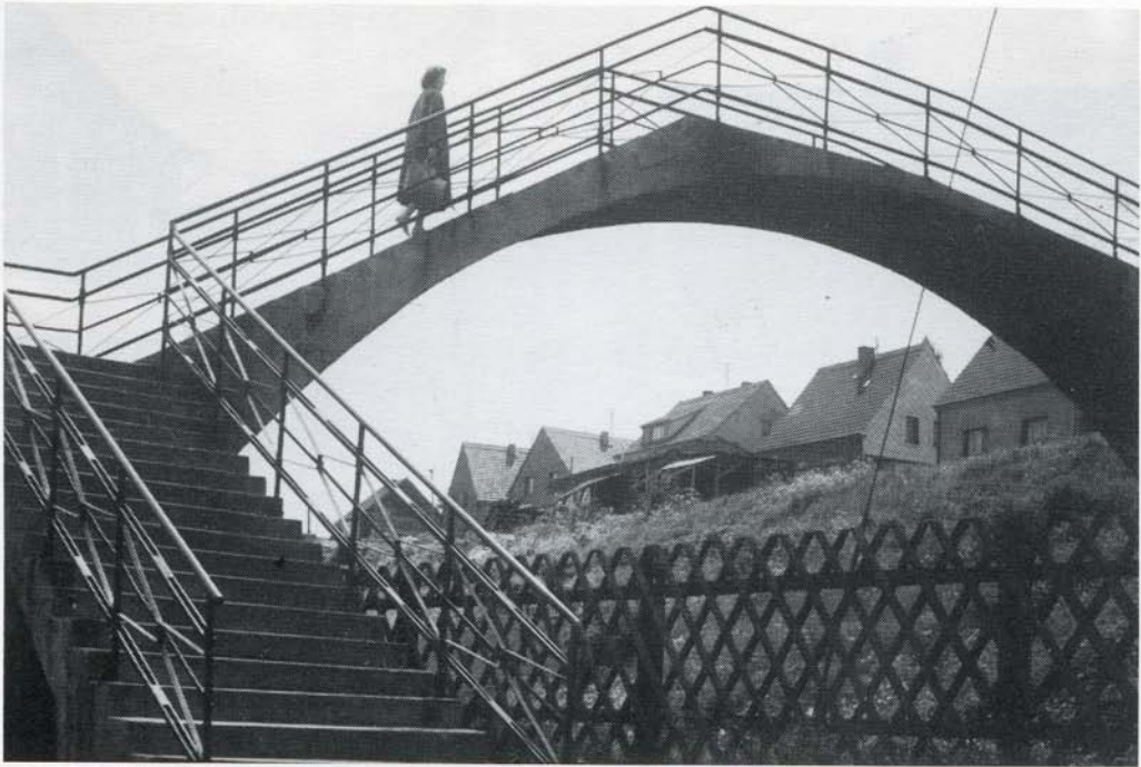
Die alte Zementbrücke mußte der Elektrifizierung weichen. (Foto: Alfons Bick)
