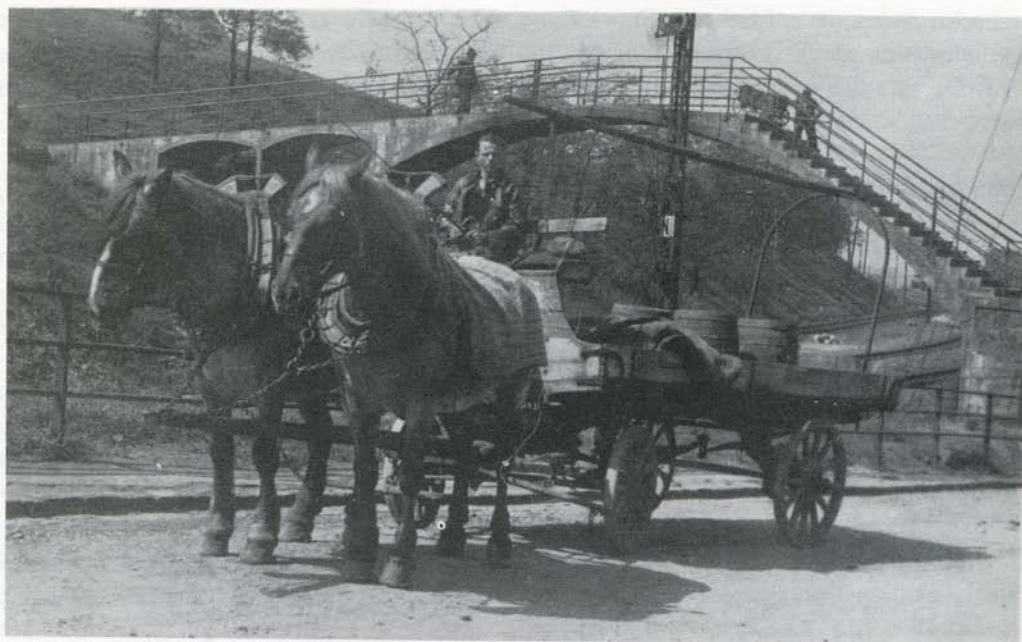
Die bei der Elektrifizierung abgerissene Zementbrücke
