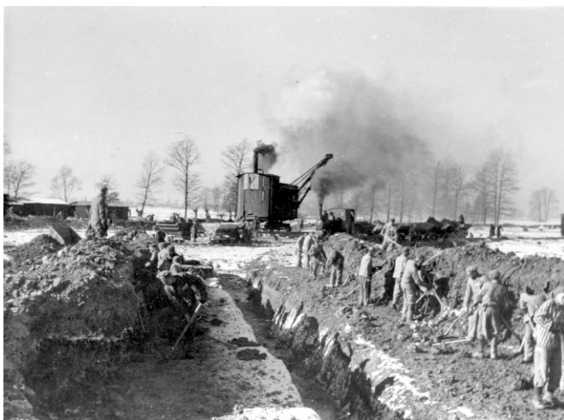
Ausbau von Birkenau. Häftlinge heben Drainage- und Versorgungsgräben aus.
