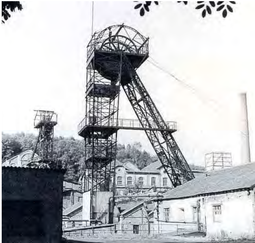
Anlage Itzenplitz. Rechts im Bild Schacht III, dahinter Schacht II
