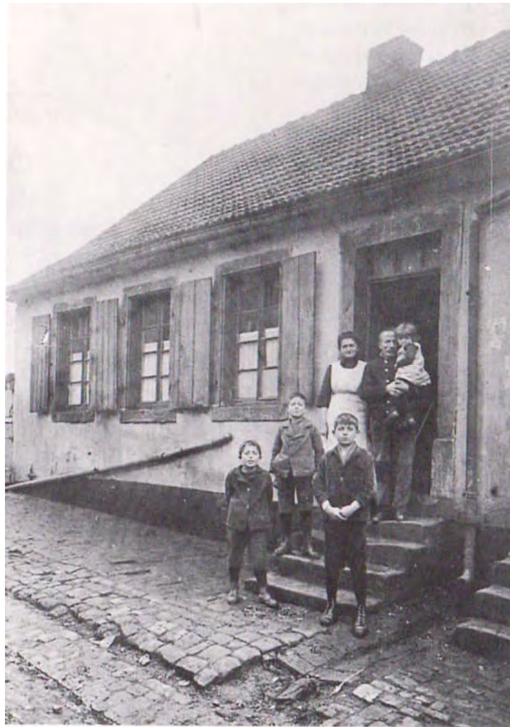
Bergmannsprämienhaus in der Karlstrasse 24, ähnlich dem der Familie Jakob Blum, das ebenfalls wegen Bergschäden abgerissen wurde.
