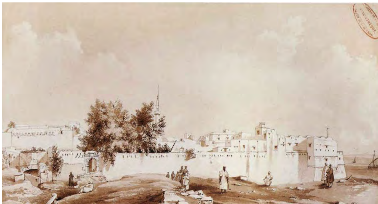
1830. Ansicht des Hafens Bab-Azoun in Algier
